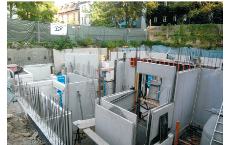
Kellergeschoss aus Doppelwand-Betonelementen
