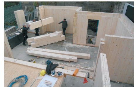
Aufstellen der Massivholzwände
