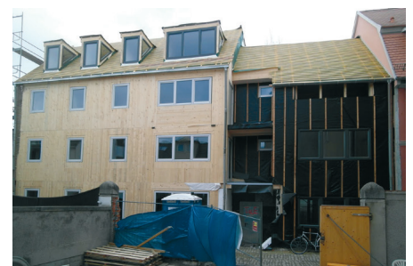
Das Dach und die Außenhülle konnten innerhalb kurzer Zeit winterfest gemacht werden
