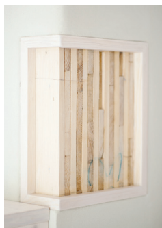
Die Holzkonstruktion wird innen sichtbar gemacht
