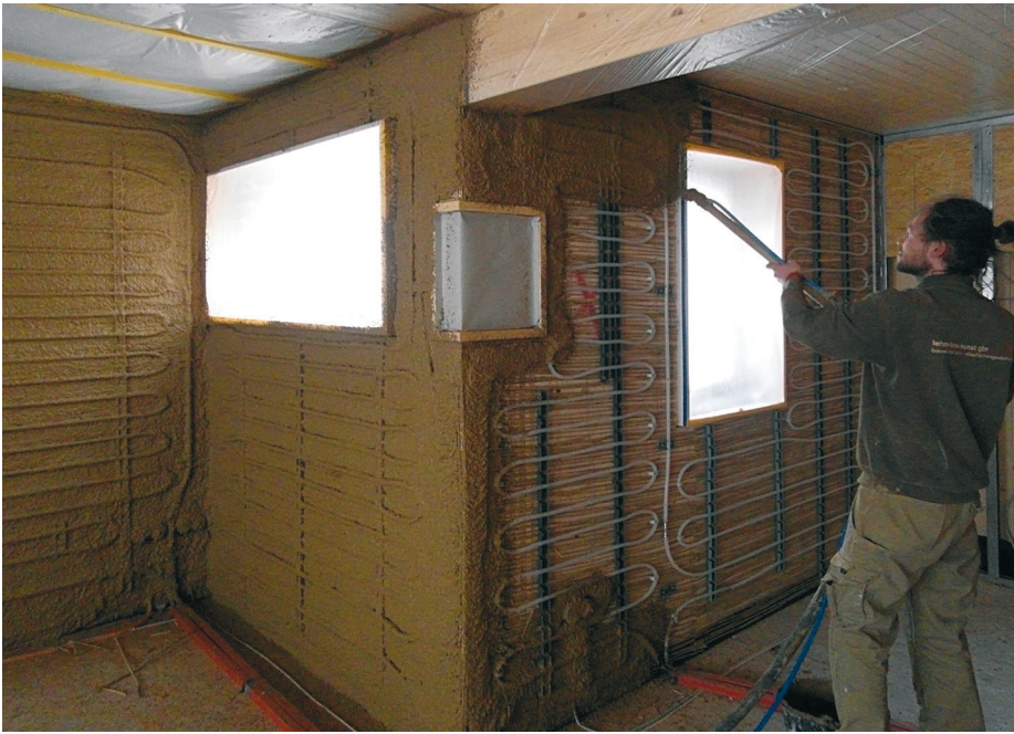
Aufbringen des Lehmputzes auf Schilfrohmatten mit montierten Wandheizungsrohren
