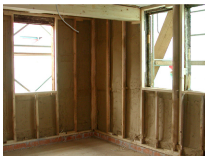
vorbereitete Außenwanddämmung
