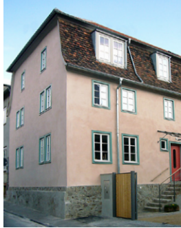
Putzfassade vor und nach der Sanierung
