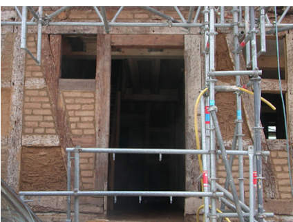
reparierte und ergänzte Außenwand
