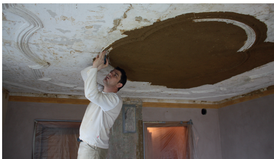
Restaurierung der Stuckdecke, Saal im Obergeschoß
