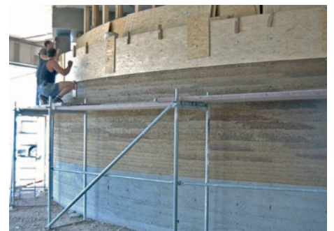
Aufbau der äußeren Stampflehmwände
