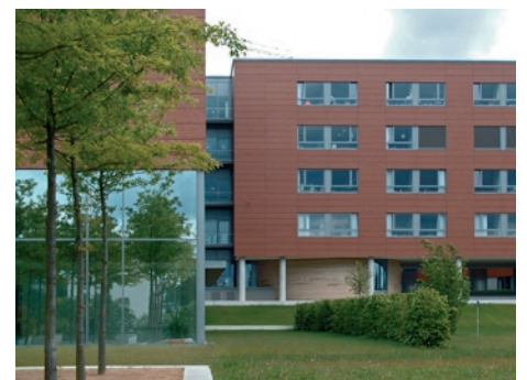
Einbindung des Stampflehm-baukörpers in das Erdgeschoss des neuen Bettenhauses.
