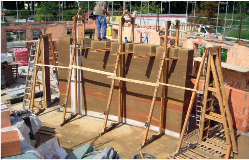
Die geschwungene Stampflehm- wand im Bau mit Aussparungen für die durchlaufenden Balken
