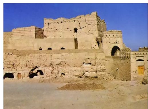
Lehmbauten in Yazd, Iran: Festung & Wasserzisterne mit Kühlungstürmen
