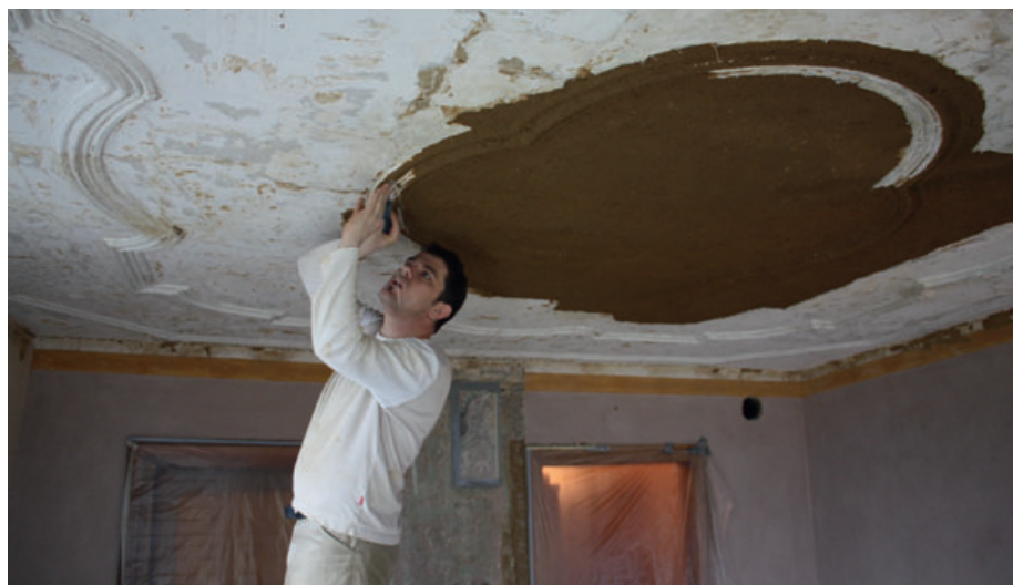
Restaurierung der Stuckdecke, Saal im Obergeschoß
