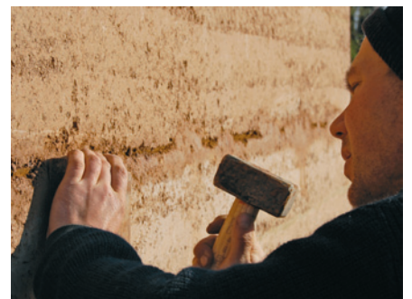
Zum Schluß wurden die Fugen in Handarbeit vorsichtig retuschiert.
