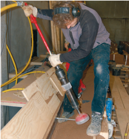
Die Vorfertigung der Wandteile erfolgte mit pneumatischem Verdichter in einer Halle der Firma conluto.
