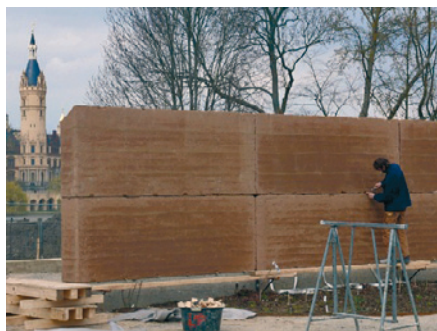
Jede Wand besteht aus sechs Fertigteilen, jedes 3 m lang in zwei Lagen übereinander.
