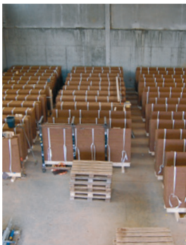
Vorgefertigte Wandteile
