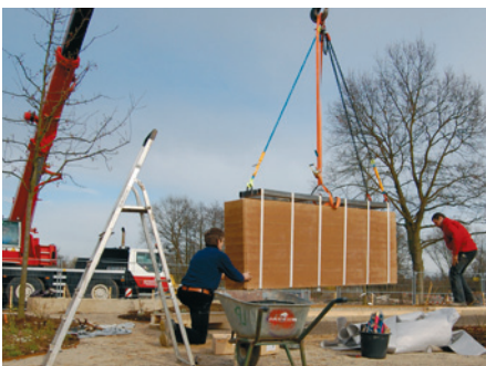
Aufstellen der Stampflehmfertigteile vor Ort auf vorbereiteten Betonfundamenten mit einem Telekran.
