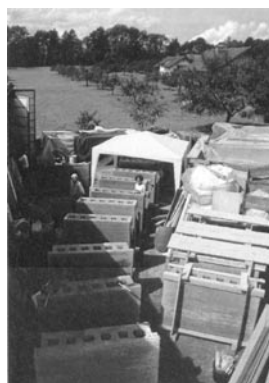
Vorfabrizierte Serien Lehmbauelemente mit integrierten Lüftungskanälen
