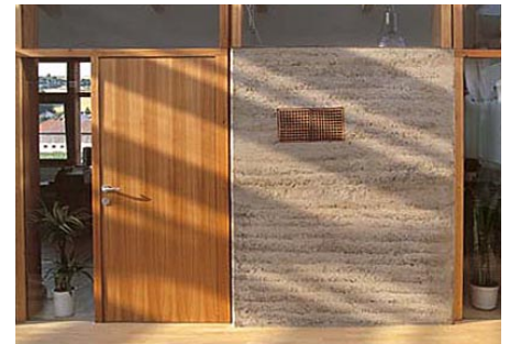
Innenansicht der Lehmwand mit Luftungseinlass
