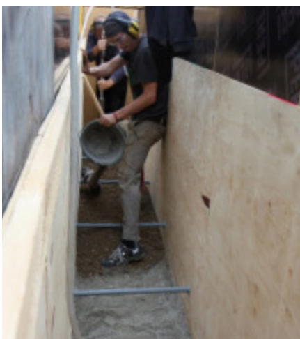
Füllung der Schalungen mit dem Lehmgemisch
