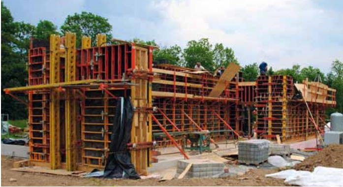
Schalung der Lehmwände
