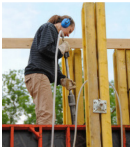
Verdichtung des Stampflehmgemisches mit Luftdruckstampfern
