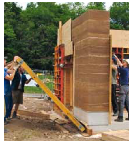
Entschalung der fertigen Wand
