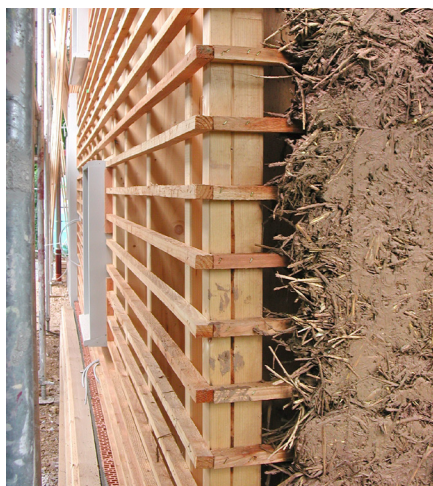
Außenwände: Strohleichtlehm auf einem Gerüst aus horizontalen Holzlaten aufgetragen
