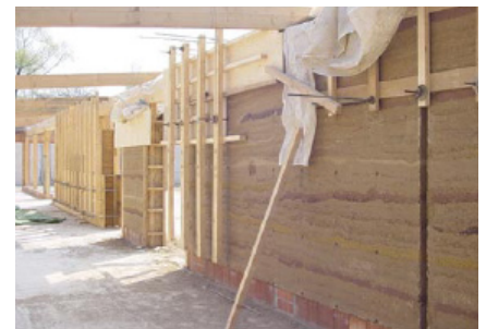
Stampflehmwand I.+II. Bauabschnitt gerade ausgeschalt, Mai 2005
