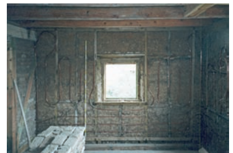
Wandheizungsrohre montiert auf einer innenseitigen Stroh-leichtlehmschale
