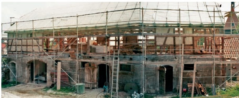
Zur Reparatur des Holzfachwerks mussten ein Großteil der Gefache entfernt werden.
