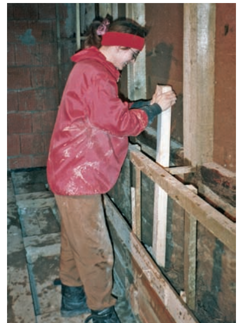
Verdichten der innenseitigen Stroh-Leichtlehmschale in Eigenleistung
