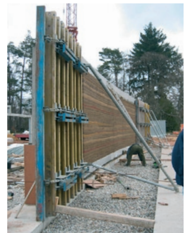
Entschalen des 1. Wandabschnitts
