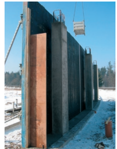
Offene Wandschalung mit Stahlbetonstützen
