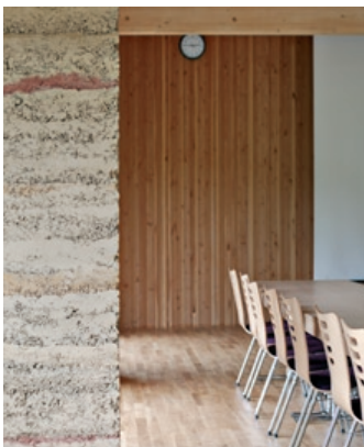
Lehm – Kiefer – Douglasie Wandschichten aus unterschiedlichen Materialien
