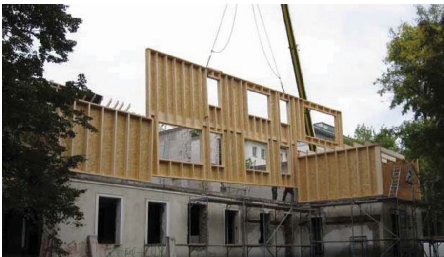
Montage vorgefertigter Wandelemente, Holzrahmenbau
