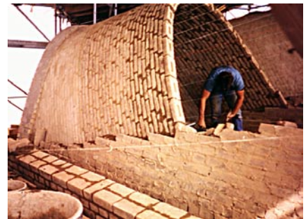
Mauern eines nubischen Gewölbes ohne Schalung
