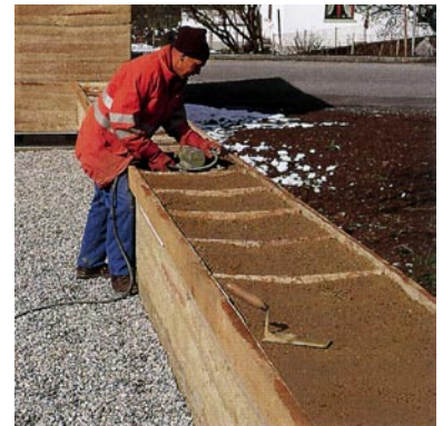
Fertigung der Mauerabdeckungen
