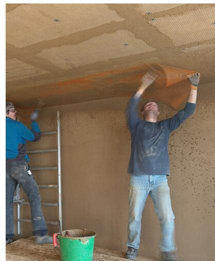
Flächiges verspachteln und verputzen der fertig montierten Decken-Klimaelemente
