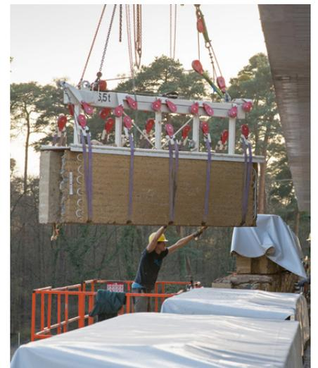
Setzen eines vorgefertigten Stampflehm-Fertigteils für einer Wandscheibe
