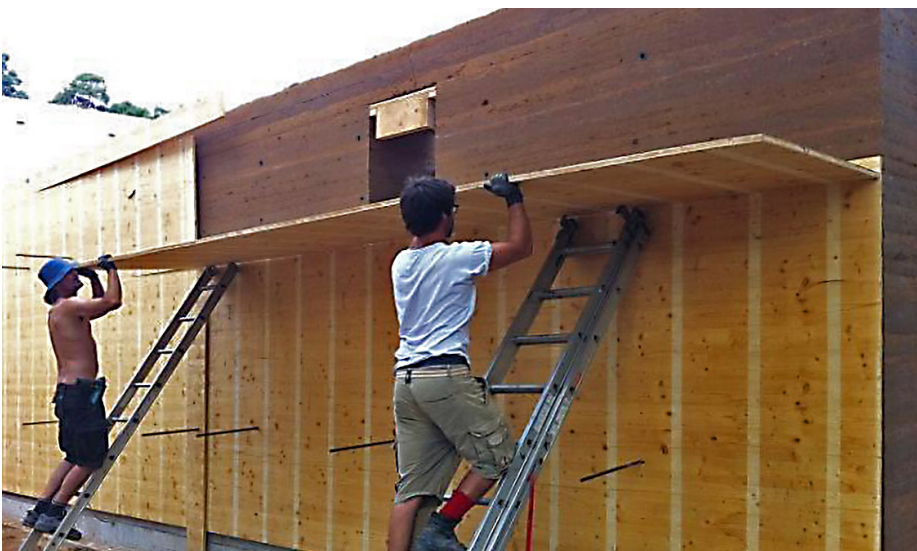
Erste Blick auf den frisch ausgeschalteten 3,5 m hohen Wandabschnitt
