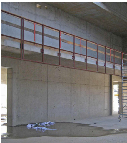
Ausgangslage: Stahlbetonkern des Foyers
