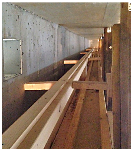
Obere Abschluss der Gleitschalung
