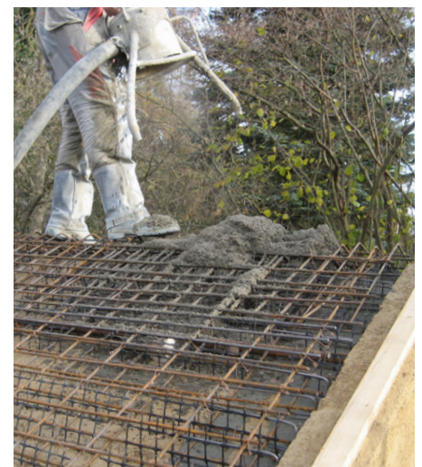
Bewehrung der Lehmplattenlagen und Eintrag der äußeren stabilisierenden Betonschicht
