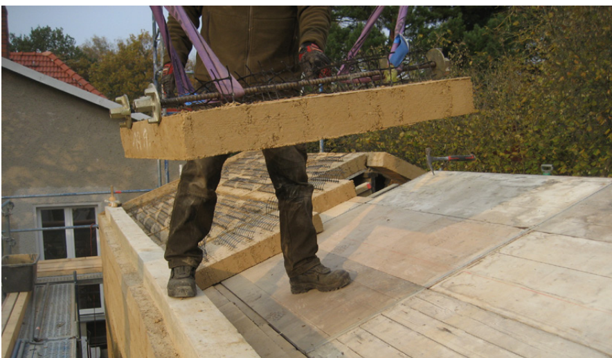
Absetzen der Fertigteile auf der Schalung mit den nach oben ausragenden Geogittern
