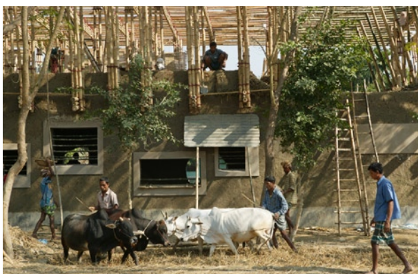
Mischen von Lehm, Wasser und Reisstroh mit Hilfe von Kühen.
