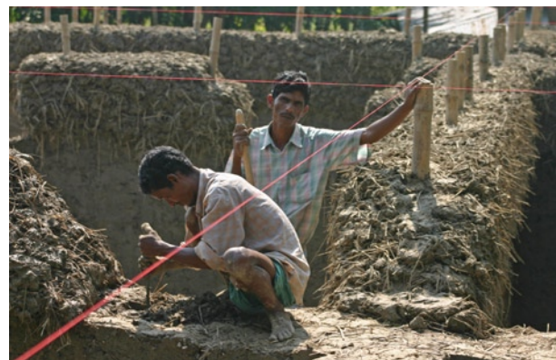
Lehmwellerbau auf einem Fundament aus Ziegelmauerwerk mit PE-Horizontalsperre. Die Wandoberfläche wurde nachträglich mit flachen Wellerspaten beschitten.
