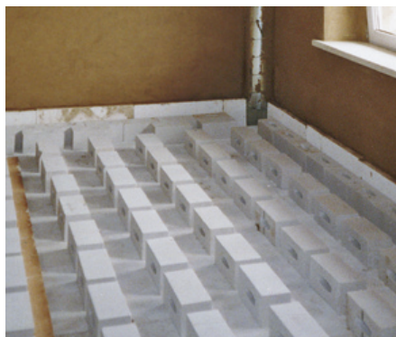
Fußboden mit KS-Steinen zur Schaffung des Hohlraums für die Hypokaustenheizung, spätere Abdeckung mit Betonplatten und Verguss mit Estrich.
