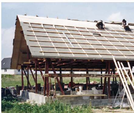
Tragendes Stahlskelett mit Dach auf der Betonplatte und Sockel vor Beginn der Lehm-bauarbeiten.
