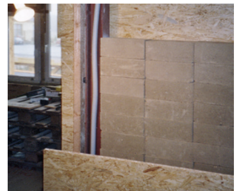
Obergeschoss: NF-Lehmsteine trocken gestapelt vor einer OSB-Platte. Anschließende Abdeckung mit einer zweiten OSB-Platte.
