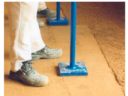
Innen liegende Leichtlehmvorsatzschale mit Schilfrohmatten
