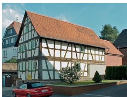
Nachher: Wiederherstellung der ursprünglichen Länge des Fachwerkhause mit dem hinteren Anbau.
