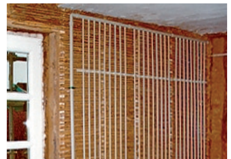
Wandheizungsregister montiert auf einer innenseitigen Vorsatzschale aus Leichtlehm.
