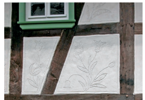
Wiederhergestelltes florales Stippputzmuster im Oberputz der Gefache.
