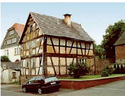
Vor der Sanierung: Alles, was vom originalen Hakenhof noch übrig geblieben war.
