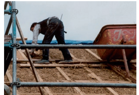
Die Sparrenfelder wurden mit Strohleichtlehm verfüllt und mit einer ca. 2 cm Lehmputzschicht verstrichen.
