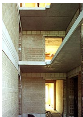
Treppenhäuserwände aus ungebrannten Lehmsteinen. Die Rückseiten der Lehmwände wirken feuchteausgleichend in den angrenzenden Bädern.
