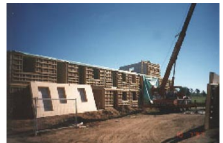
Fertigteilmontage
