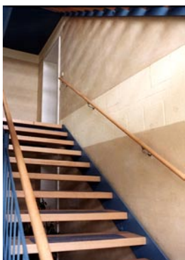
Treppenhäuserwände aus ungebrannten Lehmsteinen. Die Rückseiten der Lehmwände wirken feuchteausgleichend in den angrenzenden Bädern.
