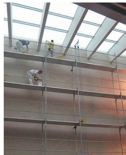
Fotos: Preite Verputz & Trockenbau
