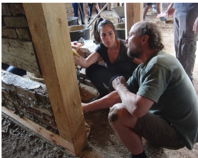
Trutz Neubarth unterweist die Schüler im Ausmauern von Gefachen mit Lehmsteinen
