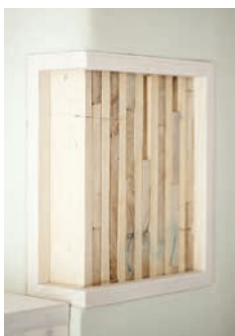
Die Holzkonstruktion wird innen sichtbar gemacht
