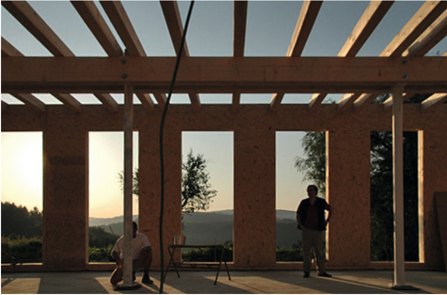
Rohbau mit Holzpaneel-Außenwänden und Tragkonstruktion aus Holz und Stahl
