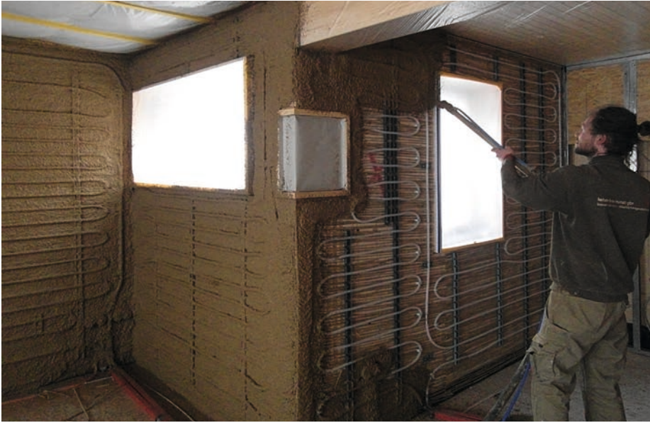
Aufbringen des Lehmputzes auf Schilfrohmatten mit montierten Wandheizungsrohren
