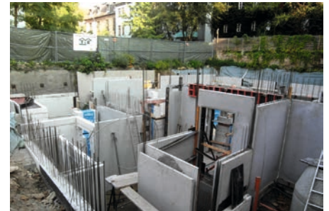
Kellergeschoss aus Doppelwand-Betonelementen
