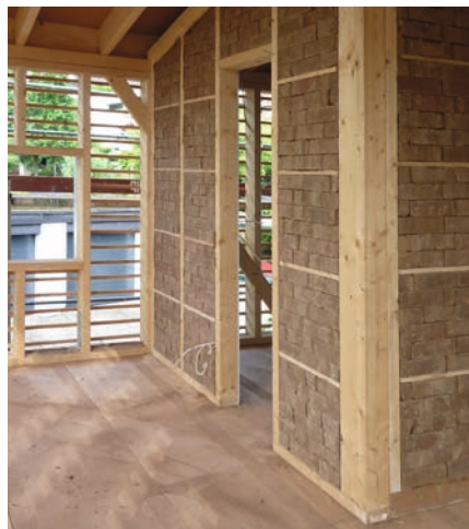
Innenwände: Lehmsteine trocken gestapelt in den Gefachen und mit Klemmleisten befestigt
