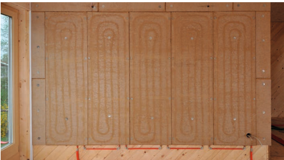
Die WEM Klimaelemente werden miteinander verbunden und an den Heizkreisverteiler angeschlossen
