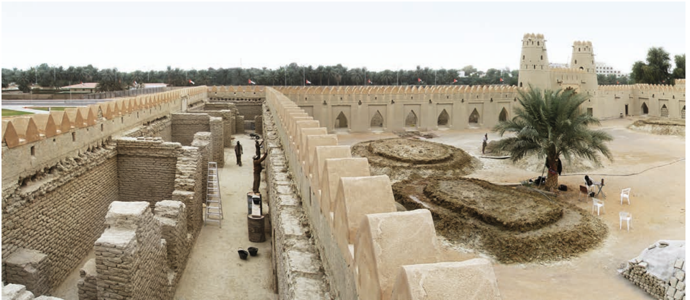
Umbauarbeiten am Jahili Fort, Abu Dhabi: rechts wird das alte Baumaterial eingesumpft für die Wiederverwendung
