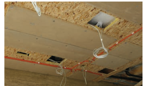
Deckenmontierte WEM Klimaelemente
