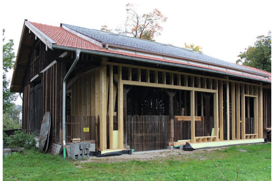
Alte Torfremise mit neue Nutzung: Korbflechterwerkstatt, Kolbermoor
