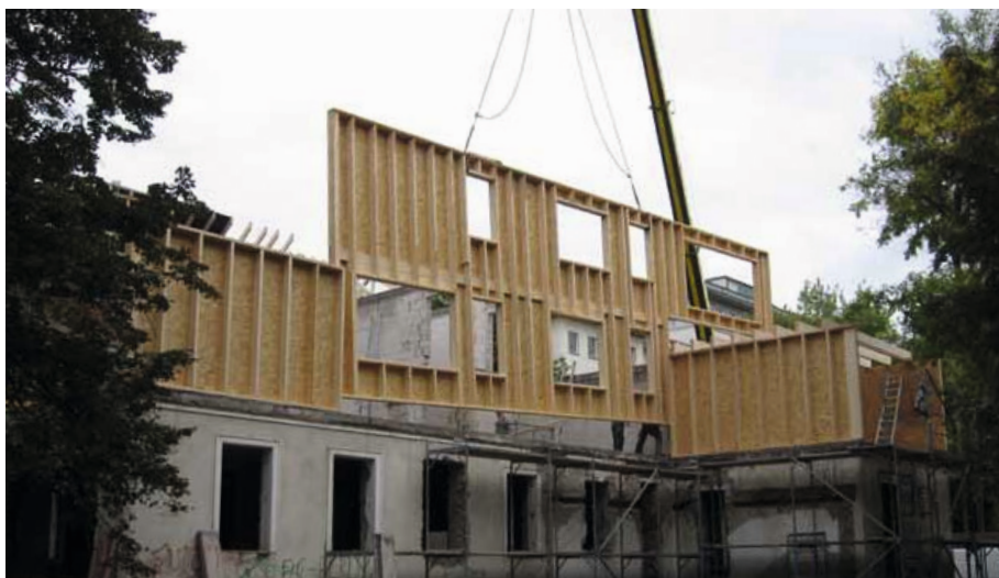
Montage vorgefertigter Wandelemente, Holzrahmenbau
