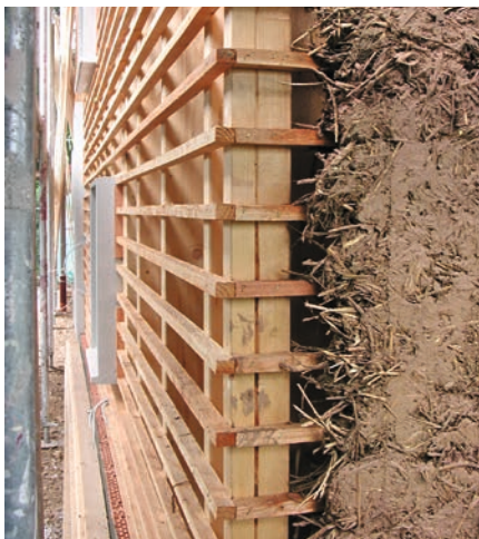
Außenwände: Strohleichtlehm auf einem Gerüst aus horizontalen Holzlatten aufgetragen
