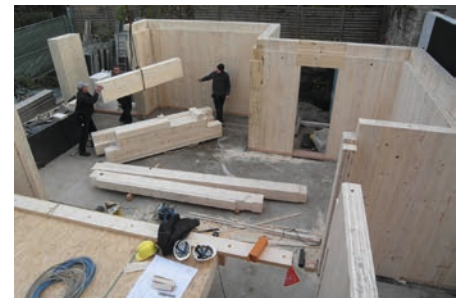
Aufstellen der Massivholzwände
