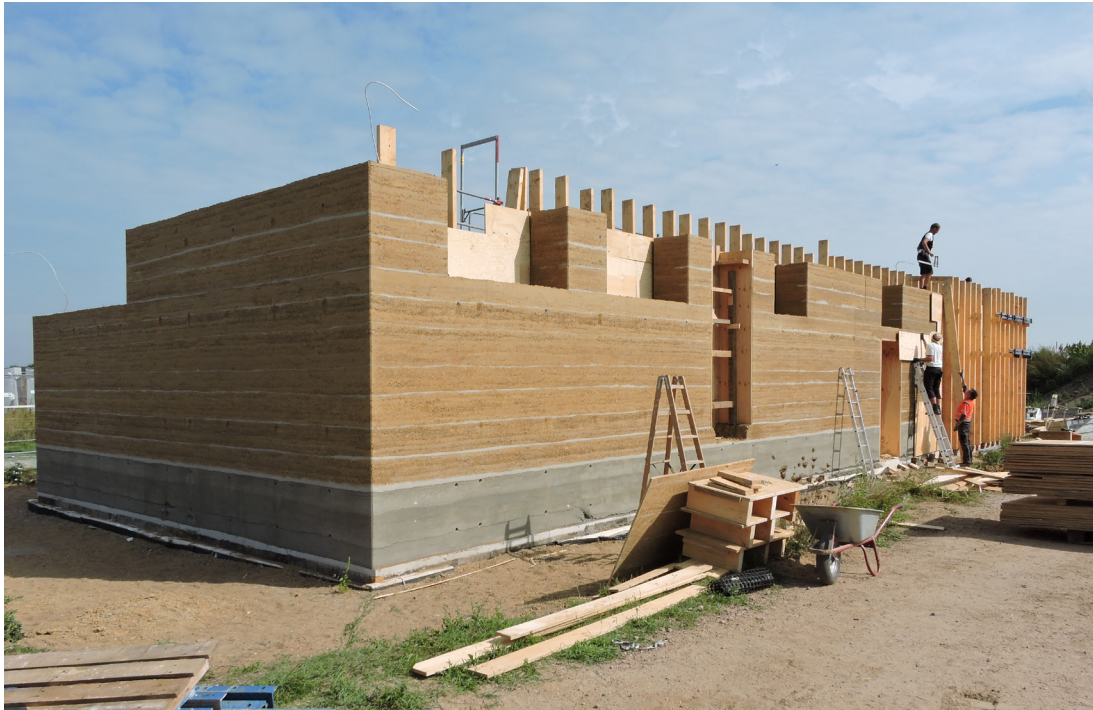
Stampflehmbaustelle in Pömmelte. (Foto: Stephan Jörchel)
