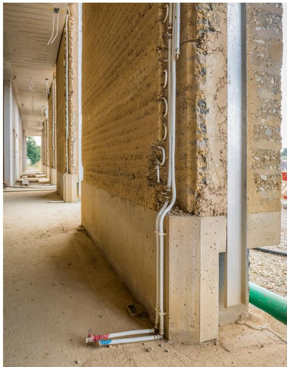
10 Innenseite von einem der Stampflehmelemente mit integrierten Wandheizung und Schaumglasschotter-Kerndämmung
