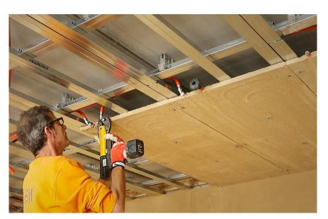
07 Die Klimaelemente wurden an die Deckenkonstruktion geschraubt und die Rohrleitungen durch Verpressen miteinander verbunden
