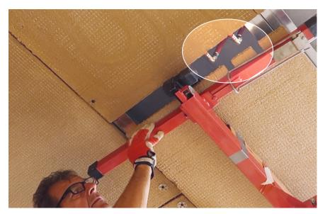
06 Vorgefertigt ausgefräste Lehmplatten nehmen die Rohrverbindungen der WEM Klimaelemente auf und sorgen für eine durchgehende Fläche zum Verputzen
