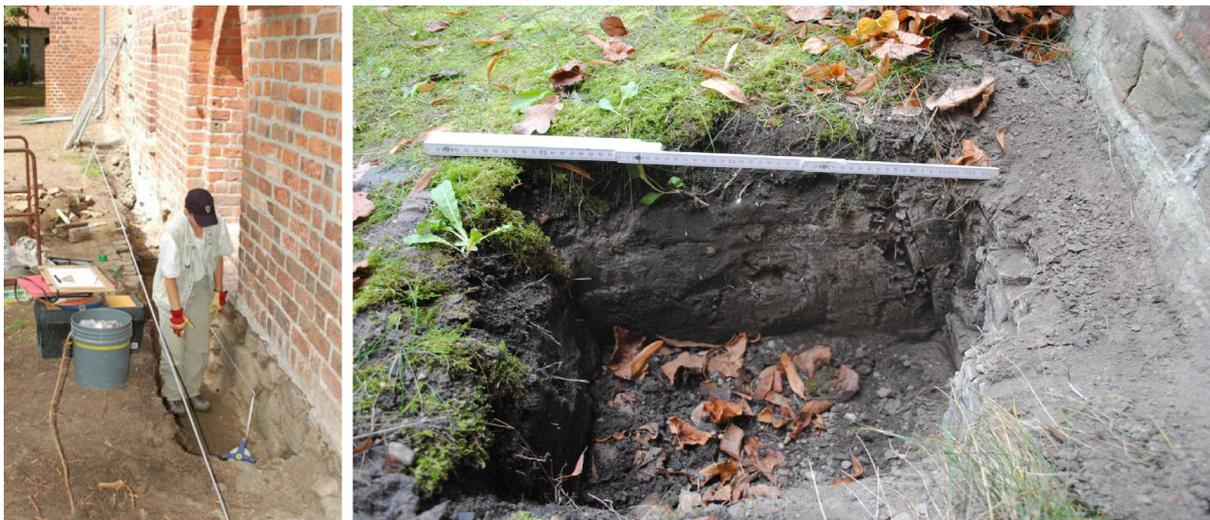
02 Nachträgliche Mauerwerksabdichtungmaßnahme an der Heilige-Geist-Kirche, Teupitz (gebaut 13/14 Jh.). Eine Vertikalsperrschicht wurde 2008 mit einem lokalen Grubenlehm ausgeführt (linkes Foto, von T. Wondoll). Die Abdichtung wurde 2014 auf Dichte überprüft und als funktionsfähig beurteilt (Michette 2015) (rechtes Foto).
