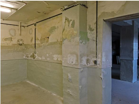
03a und b "Sanierung" von Souterrainräumen mittels Sperranstrich ohne Einbau einer Horizontalsperre 5 Jahre nach der Maßnahme. Die Verdunstungszone verschiebt sich nach oben und der Anstrich platzt auf.
