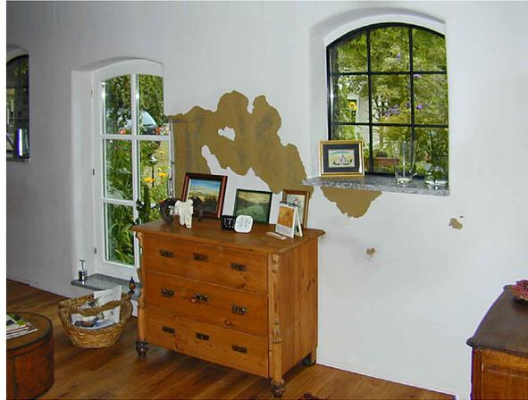
04 Putz- und Anstrichschäden trotz Einbau einer Horizontalsperre aber ohne Maßnahmen zur Salzreduktion
