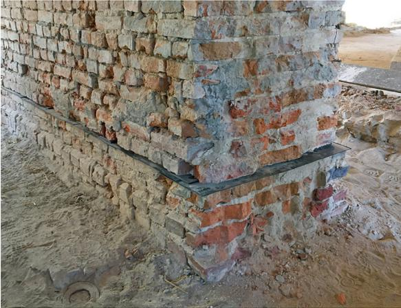
**05 Einbau einer mechanischen Horizontalsperre im Mauer sägeverfahren als vorbereitende Maßnahme für die Entsalzung**
