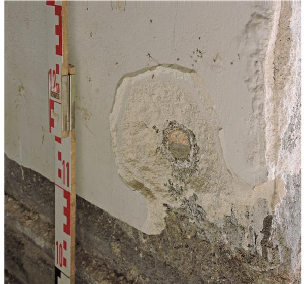
09a und b Zu großer Abstand der Bohrlöcher der chemischen Horizontalsperre der 1980er Jahre. Das Injektionsmittel war zudem mit dem Bestand chemisch und physikalisch unverträglich.
