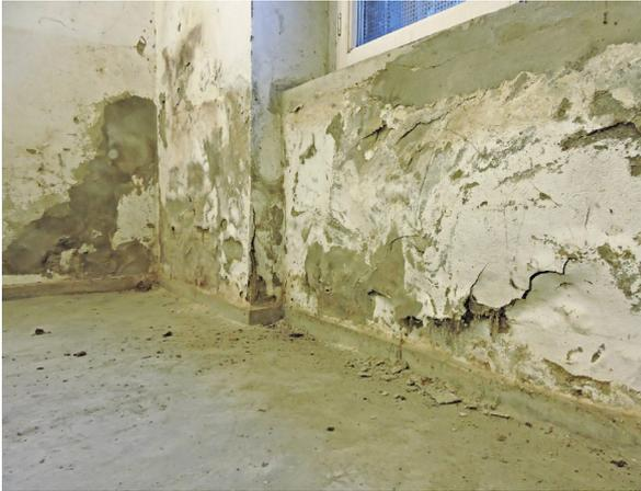
02 Sanierputz nach 10 Jahren Standzeit ohne Einbau einer Horizontalsperre
