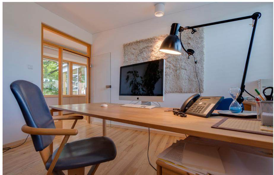
04 Lehmbauplatten an der Wand, Lehmputz auf Holzweichfaserplatten an der Decke & Kalkfarbe
