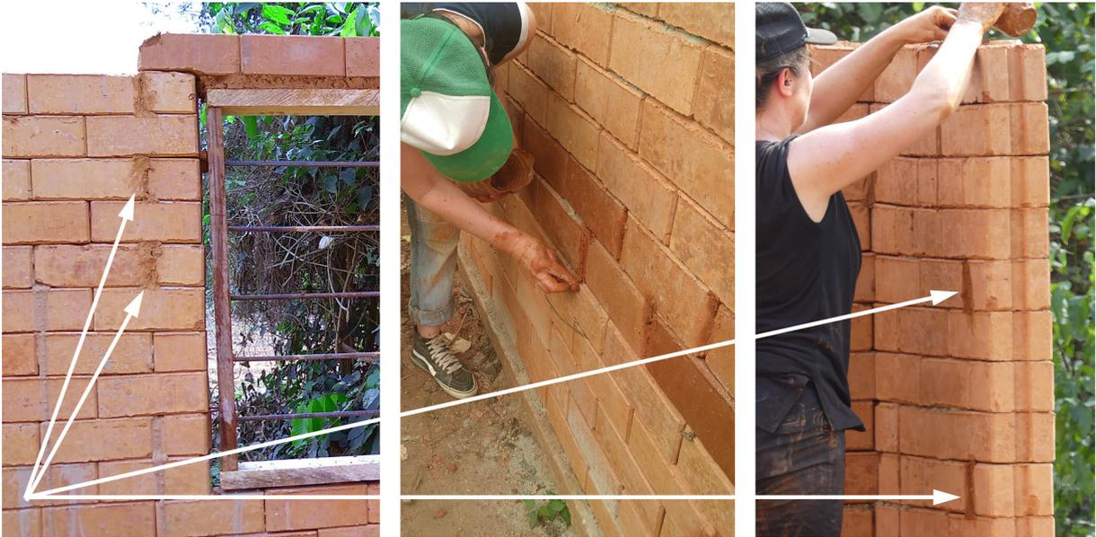
08 Das Herausfließen des vertikalen, flüssigen Laterit-Vergusses muss an behauenen Steinenden durch eine vorab applizierte, pastose Lateritmischung verhindert werden (siehe Pfeile)
