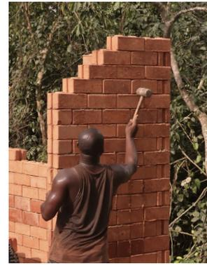
09–11 Das Ausgleichen von kleinsten Niveau-Abweichungen durch Sand ist besonders in den unteren Steinlagen wichtig, da sich Ungenauigkeiten addieren. Die vertikale Lotreichtigkeit kann durch einen Gummihammer korrigiert werden.
